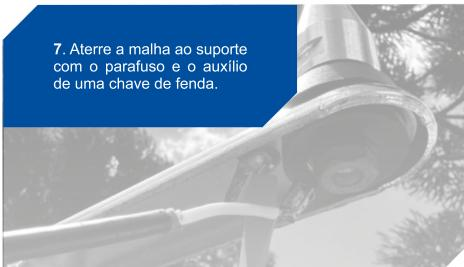
7. Aterre a malha ao suporte com o parafuso e o auxílio de uma chave de fenda.
